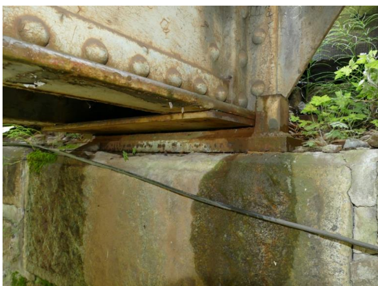
Konstrukce K 01: Ložisko na opěře O 01 vpravo – odpadlé obetonování
