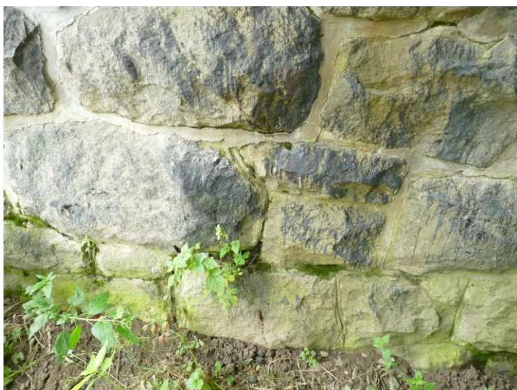
Opěra O 01: Dřík – vypadané spárování
