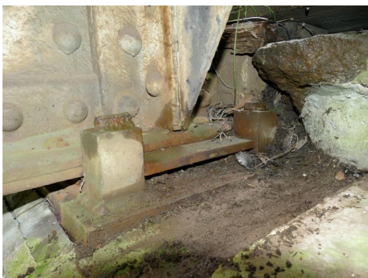
Konstrukce K 01: Ložisko na opěře O 02 vlevo – prosedlé směrem k závěrné zdi
