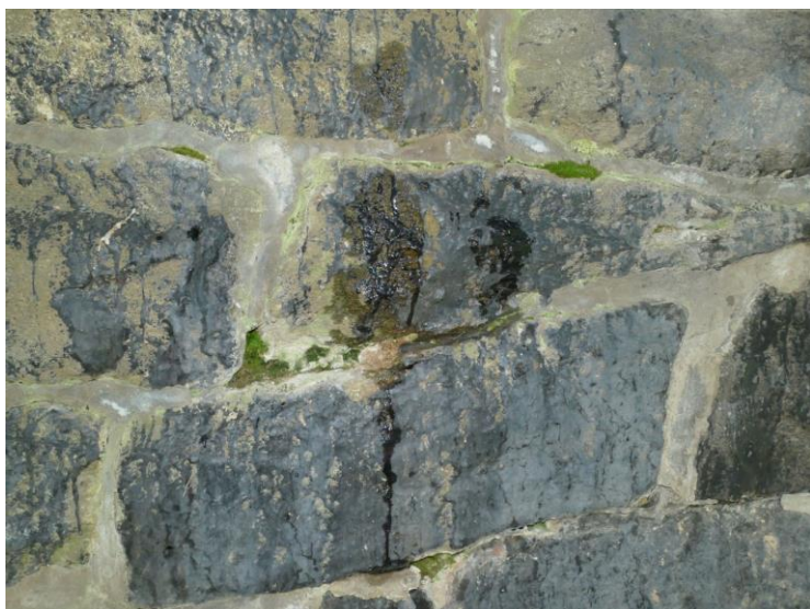
Opěra O 01: Dřík – průsaky vody
