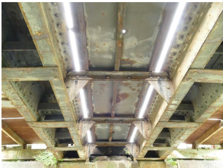
Konstrukce K 01: Porušená PKO
